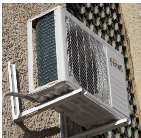
Fig. 7a, b, c – Exemplu: Montarea aparatelor locale de climatizare de fereastră
