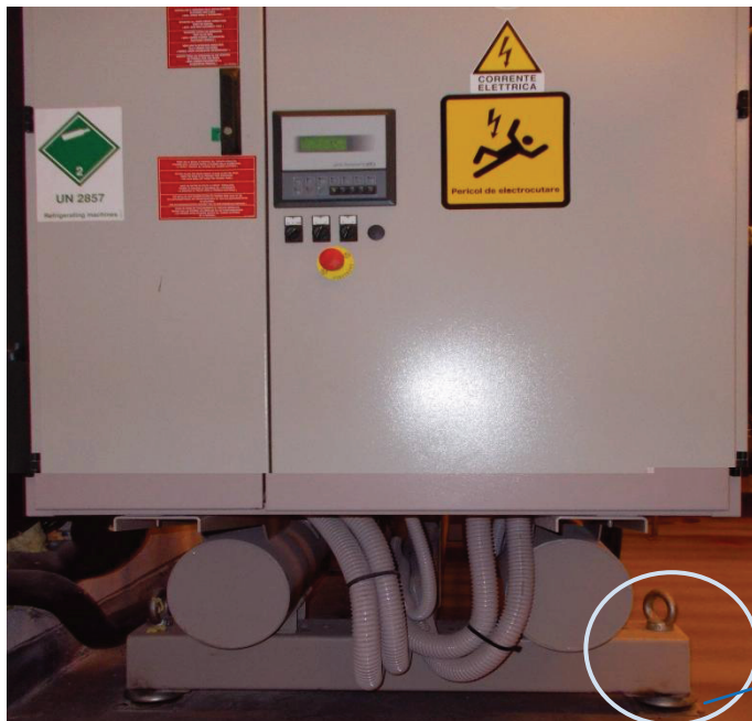
Fig. 1a, b – Dulap automatizare instalație ventilare/ climatizare clădire birouri – montaj rigid la pardoseala cu izolatori/ amortizoare de vibrații (b)
