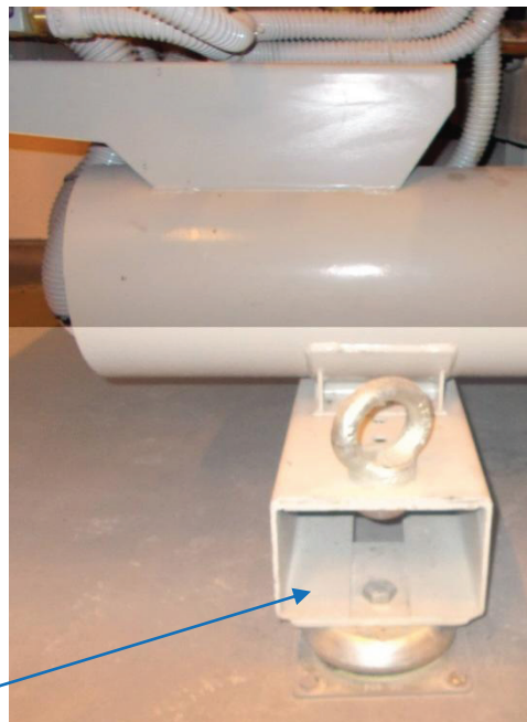
Fig. 1a, b – Dulap automatizare instalație ventilare/ climatizare clădire birouri – montaj rigid la pardoseala cu izolatori/ amortizoare de vibrații (b)
