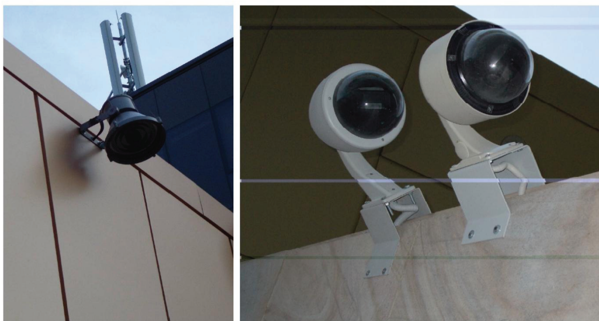
Fig. 6 – Corpuri iluminat exterior fixate rigid, ancorat de anvelopa clădirii
